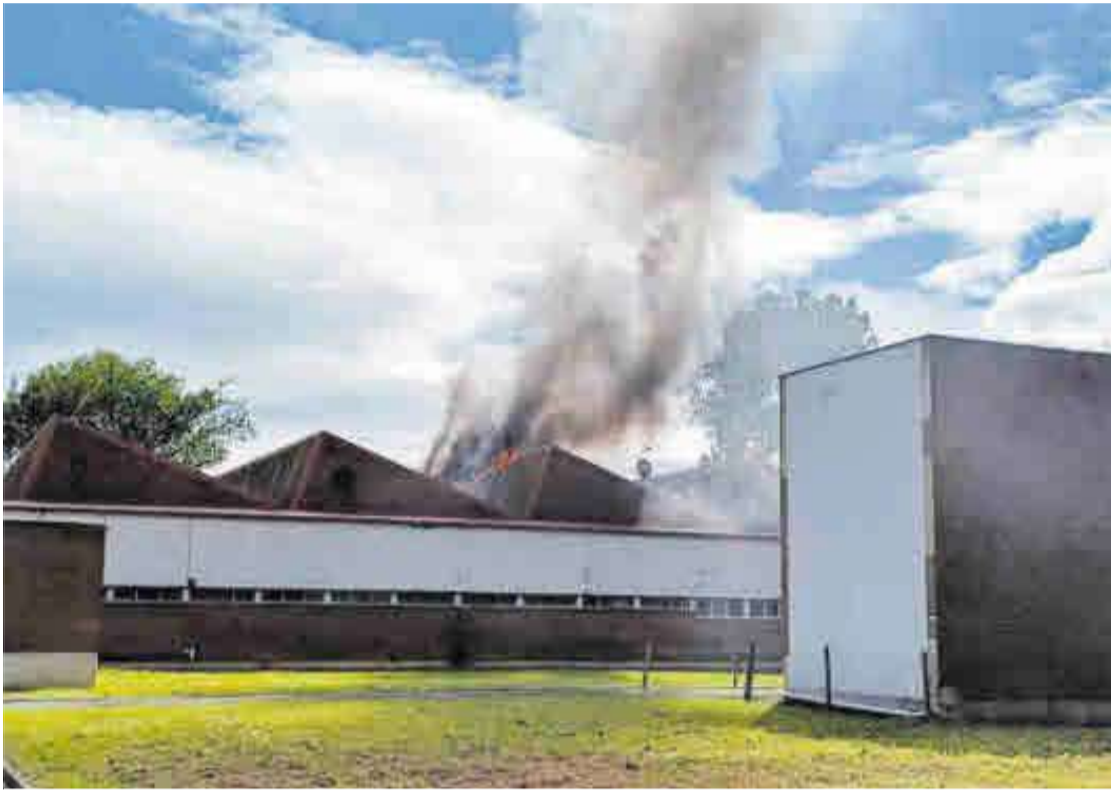
Las llamas en el tejado del instituto. | Ayuntamiento de Noreña
